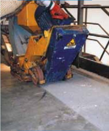
Der Untergrund wird mittels Kugelbestrahlung vorbereitet
