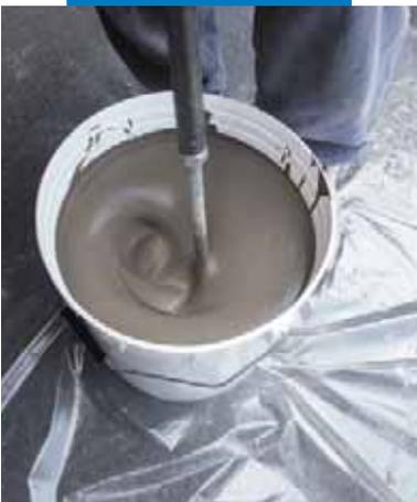
Anmischen des Produktes mittels einem langsam laufenden Rührwerkes
